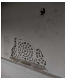
Figura 9 – Revestimento quebrado
