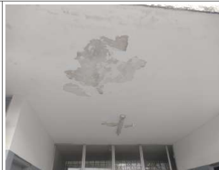
Figura 7 – Infiltração
