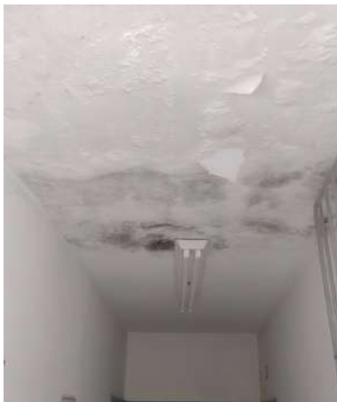
Figura 5 – Infiltração na Laje
