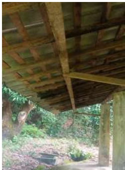
Figura 20 – Estrutura do telhado comprometida
