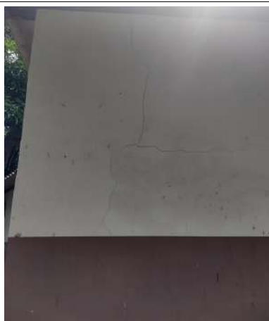
Figura 5 – Alvenaria fissurada
