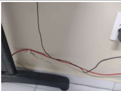
Figura 8 – Descamação causada pela umidade
