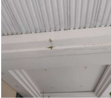
Figura 11 – Infiltração
