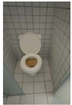
Figura 16 – Vaso entupido
