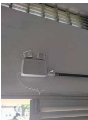
Figura 13 – Iluminação de emergência
