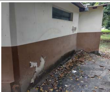
Figura 8 – Alvenaria fissurada e tinta descascando
