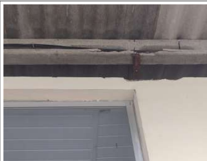
Figura 6 – Ferragem exposta na viga
