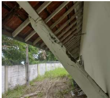
Figura 6 – Infestação de cupins
