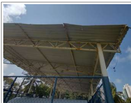
Figura 5 – Telhas/estrutura oxidada
