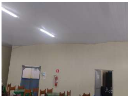
Figura 11 – Forro régua de PVC cedendo
