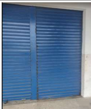
Figura 6 – Porta de aço com pontos de oxidação
