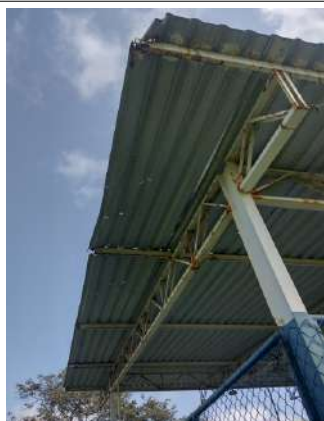
Figura 8 – Telhas quebradas
