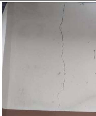
Figura 6 – Alvenaria fissurada
