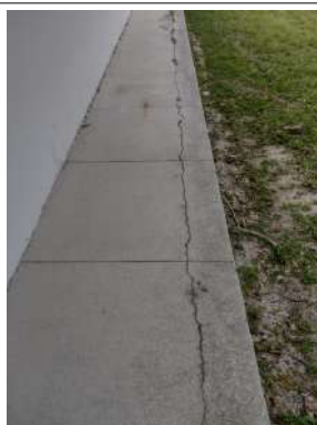
Figura 6 – Fissura no piso
