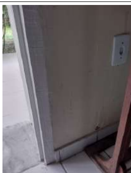
Figura 9 – Infiltração
