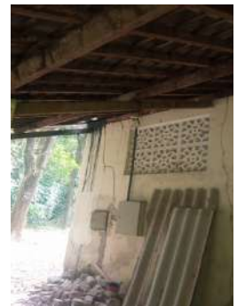
Figura 19 – Estrutura do telhado comprometida
