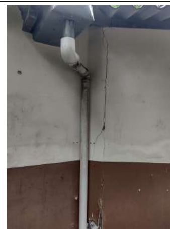
Figura 7 – Alvenaria fissurada
